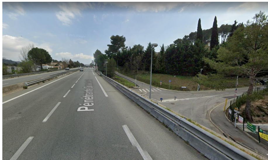
Vue sur le site depuis la pénétrante (source : Google)
