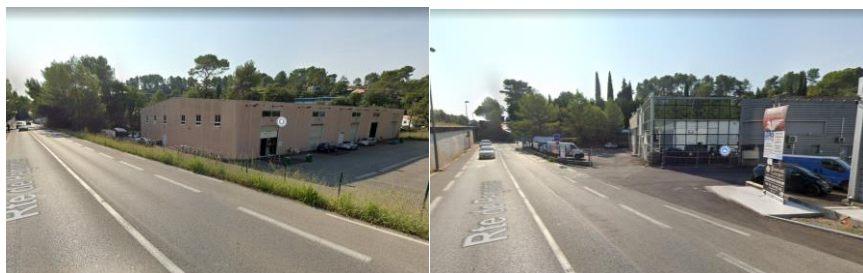
Vues sur la zone d'activités du Tiragon depuis la pénétrante (source : Google)
