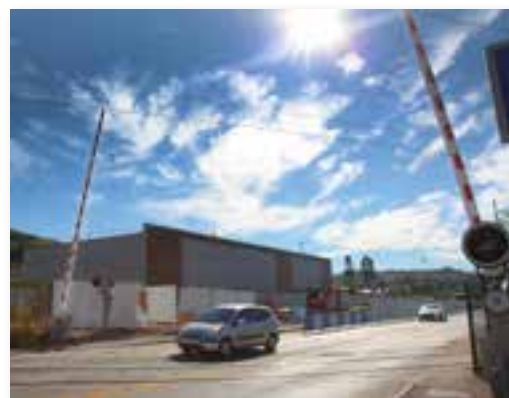
le passage à niveau n°5
