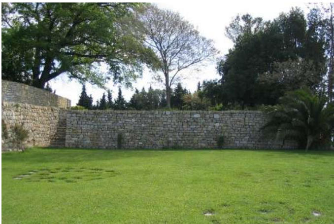
Le réservoir de CASTELLARAS II grande cuve (1964)
