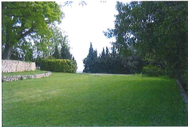
Le réservoir de CASTELLARAS II petite cuve (1961)
