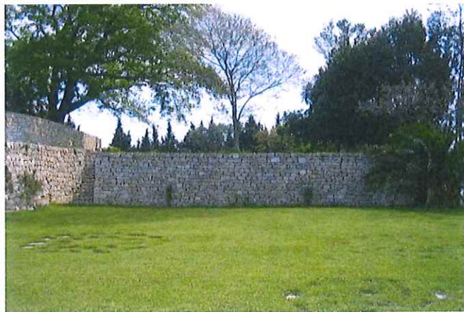
Le réservoir de CASTELLARAS II grande cuve (1964)
